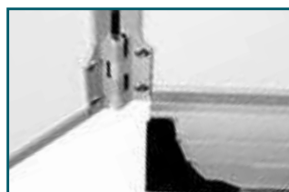
détail charnière et coin de protection auget
